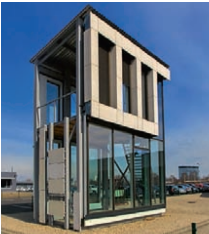
Topošā darījumu centra New Hanza City teritorija un ABLV Bank jaunās ēkas fasādes materiālu testa mock-up
