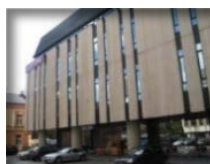
Office building Palangos str. 4/ Vilniaus str. 33 Vilnius
