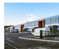
„Dommo business park“ Riga Latvia
