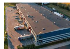
„Dommo business park“ Riga Latvia
