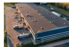
„Dommo business park“ Riga Latvia
