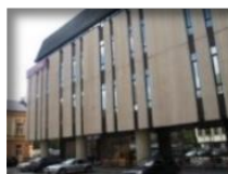
Office building Palangos str. 4/ Vilniaus str. 33 Vilnius
