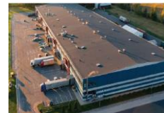
„Dommo business park“ Rīga Latvia
