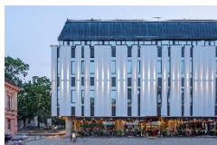
Office building Palangos str. 4/ Vilniaus str. 33 Vilnius
