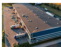
„Dommo business park“ Riga Latvia
