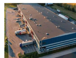
„Dommo business park” Riga Latvia
