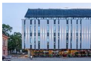
Office building Palangos str. 4/ Vilniaus str. 33 Vilnius
