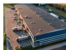
„Dommo business park“ Riga Latvia
