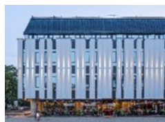
Office building Palangos str. 4/ Vilniaus str. 33 Vilnius
