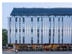
Office building Palangos str. 4/ Vilniaus str. 33 Vilnius
