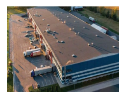
„Dommo business park” Riga Latvia
