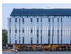
Office building Palangos str. 4/ Vilniaus str. 33 Vilnius
