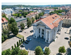
Building of Pramogų bankas A. Stulginskio str. 8 Vilnius
