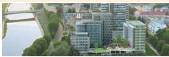
Daugiabučių gyvenamųjų namų kompleksas „Nida“ Vilniuje. Complex of multi - dwelling buildings Nida, in Vilnius.
