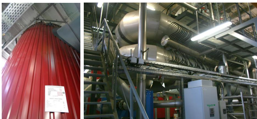
Nuotr.: naujasis vandens šildymo katilas ir kondensacinis ekonomaizeris „Šilko“ katilinėje
