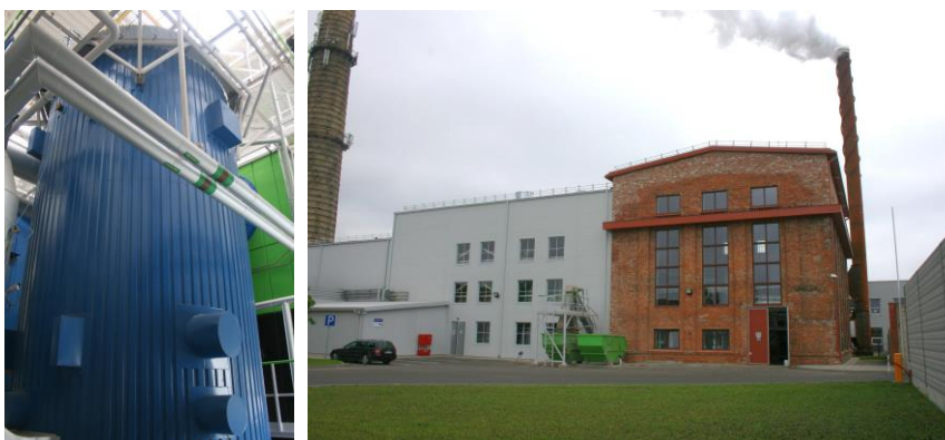
Nuotr.: vienas iš naujųjų biokuro katilų ir atnaujintas „Inkaro“ katilinės pastatas
