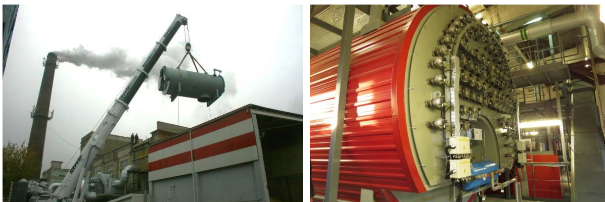
Nuotr.: naujas biokuro kūrenamas vandens šildymo katilas keliamas per katilinės stogą ir sumontuotas vietoje
