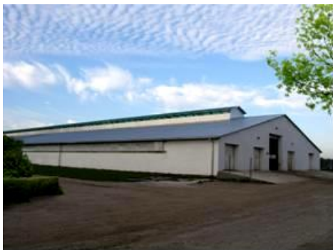
Rekonstruotas fermos pastatas, Želsvelės žemės ūkio bendrovė
